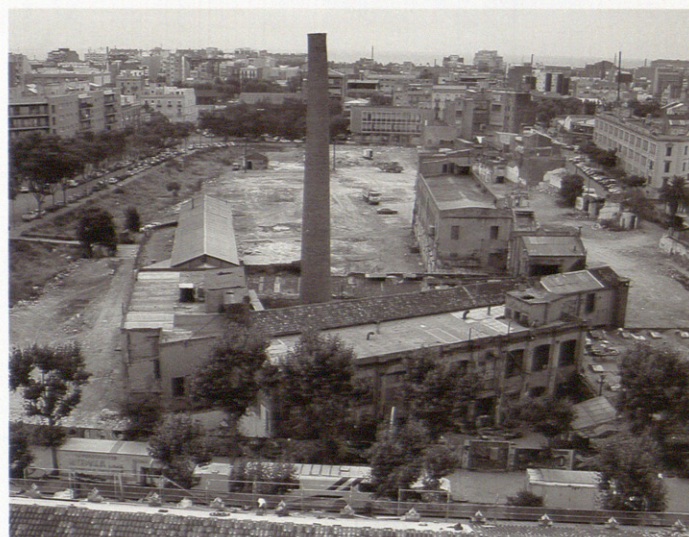
Vista de la fábrica original antes y después de su demolición.
